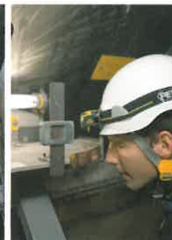
Surveillance du barrage à l'aide d'un pendule
