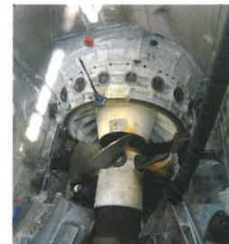
Rénovation du groupe de production n° 2
